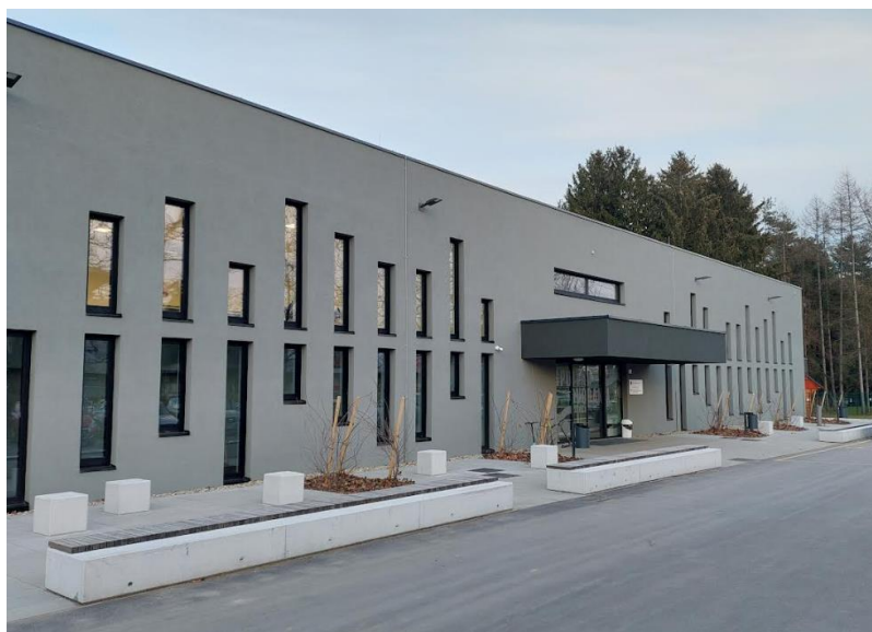
Foto 2: Obnovljena športna dvorana pri OŠ Pohorskega odreda Slovenska Bistrica
